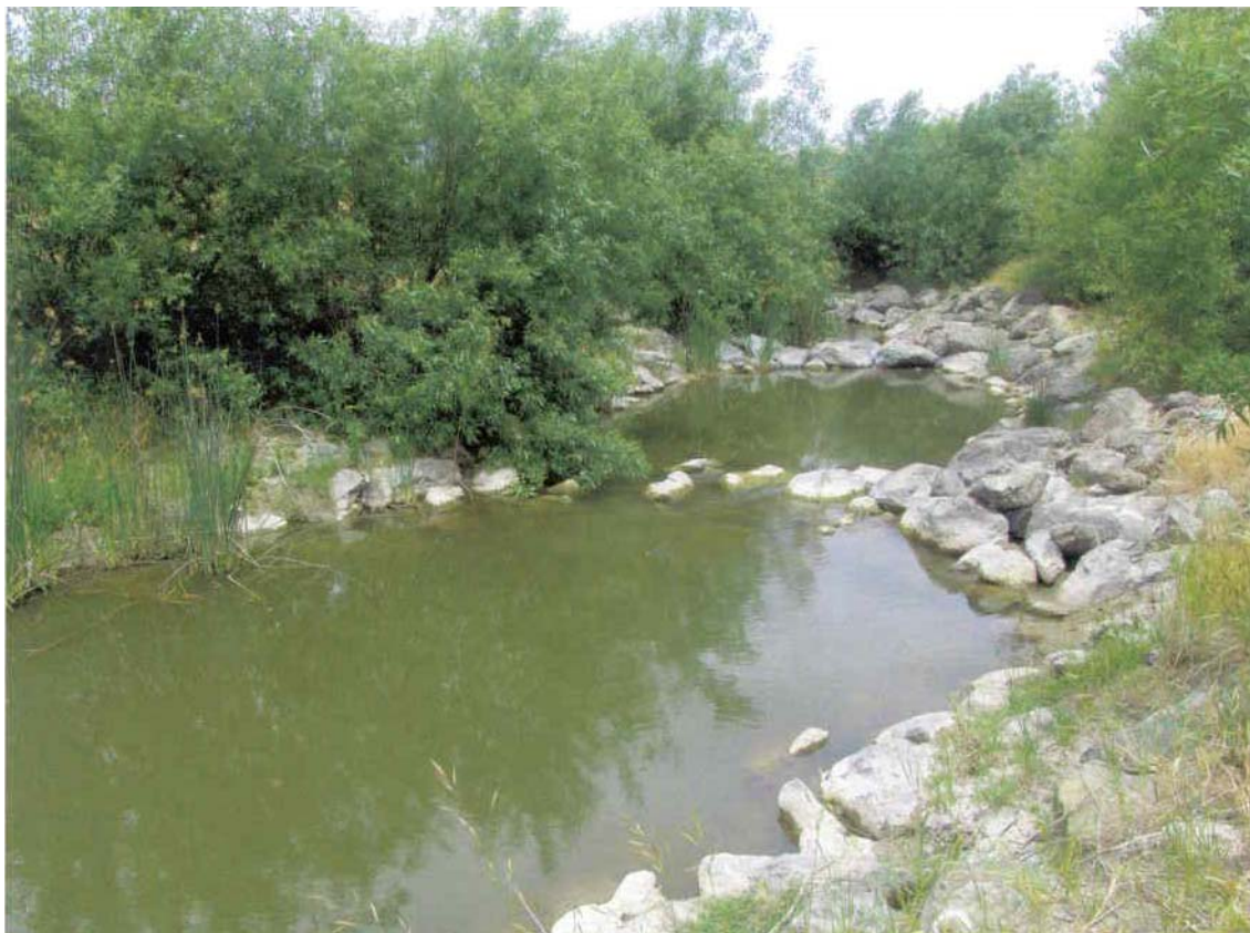
Figura 2.8. Imagem ilustrativa da solução baseada em linhas transversais de pequenos “diques” de pedra para estabilização do leito
